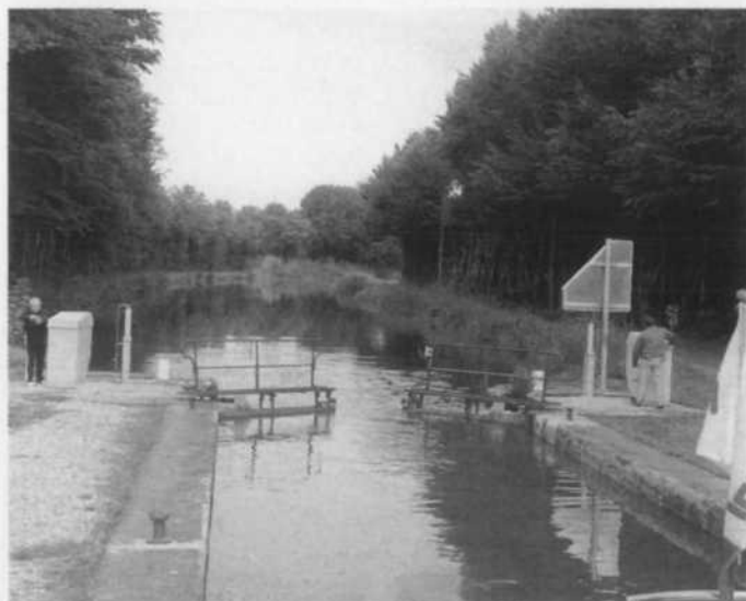
★ Handbediende sluis in het kanaal Marne-Saone.
